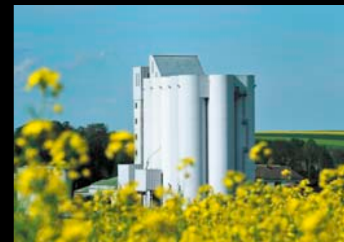
▲ SAINT-LUPIEN. Silo vertical en béton. Une technique de construction maîtrisée par quelques entreprises seulement en France, dont une à Romilly-sur-Seine (Batiteg). Pour des raisons d'étanchéité, les silos sont souvent peints.
