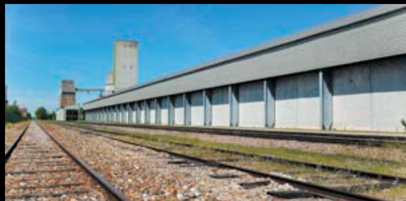
◀ SAINT-LÉGER-PRÈS-TROYES. Le retour du stockage à la ferme et la livraison en fonction des cours favorisent la multiplication des silos métalliques dans les exploitations.
