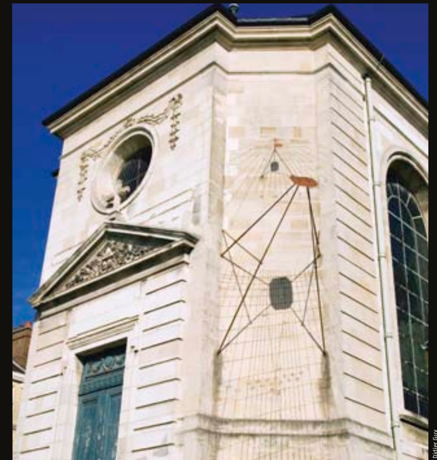
TROYES, HÔTEL-DIEU-LE-COMTE. Le chef-d'œuvre de Jean-Baptiste Ludot (1764) indique l'heure, le mois et le signe du zodiaque. Sur le pan coupé, le savant troyen a aussi dessiné une méridienne de temps moyen (courbe en 8 qui repère le midi).
