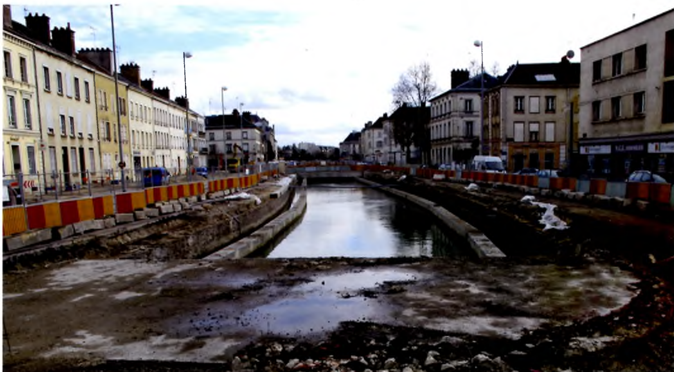
Travaux de réouverture du Canal à Troyes en 2011.
