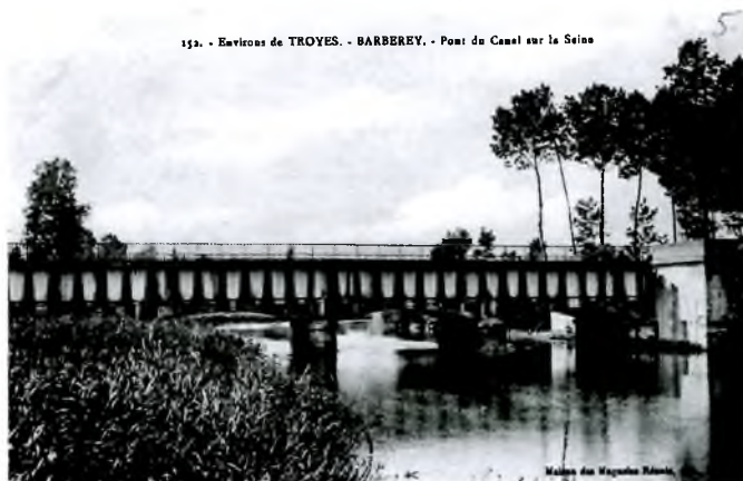
Le pont-canal de Barberey, carte postale. (Arch. dép. Aube).
