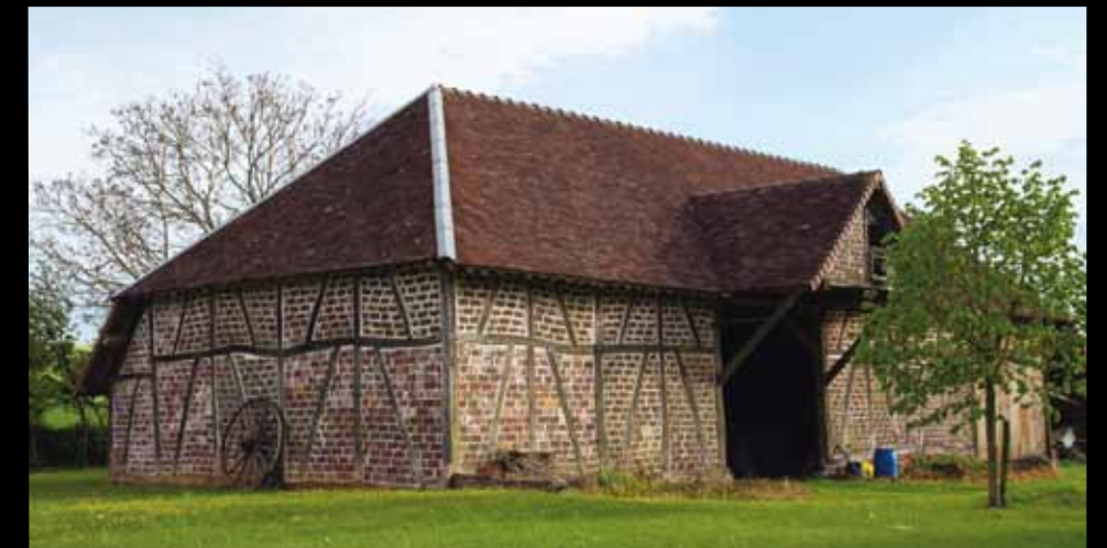
MONTGUEUX. Carreaux de craie, pan de bois rempli de briques et toitures débordantes, parfois jusqu'au sol, voilà ce qui caractérise le bâti des environs.
