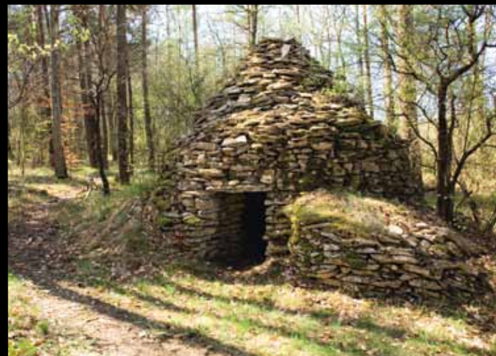
CADOLE. À Courteron et aux Riceys (photo), des circuits pédestres mettent en valeur ces anciens abris de vigneron en pierre sèche, typiques de l'Aube.
