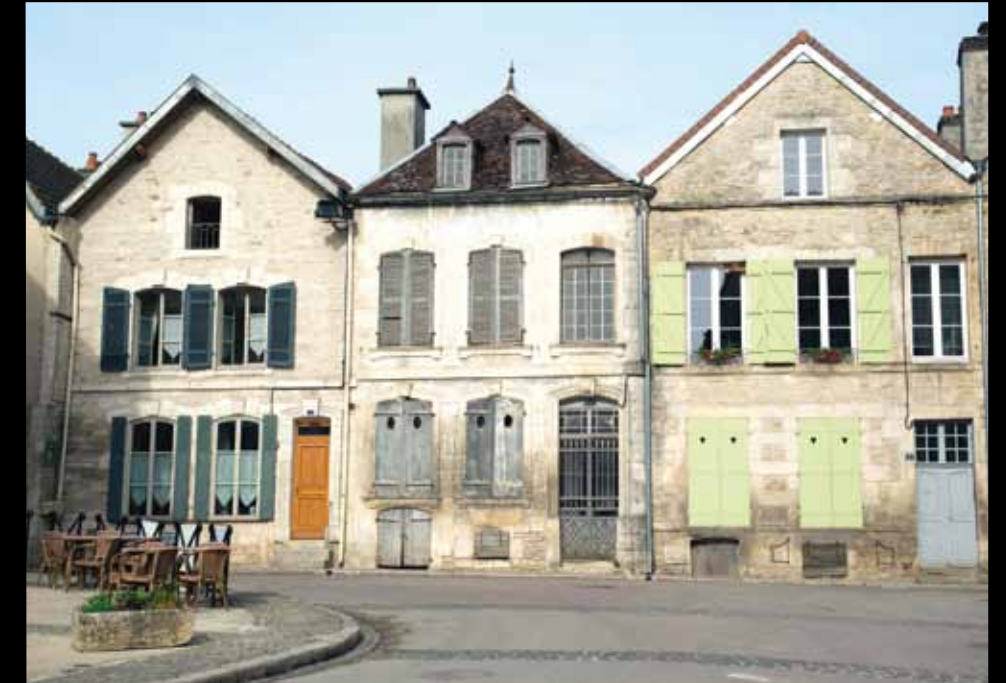
LES RICEYS. Cette commune se distingue par ses maisons de vigneron à haut pignon sur rue et sans cour. Sous ces bâtisses court tout un réseau de caves, rappelant combien la présence de la vigne est ici ancienne.
