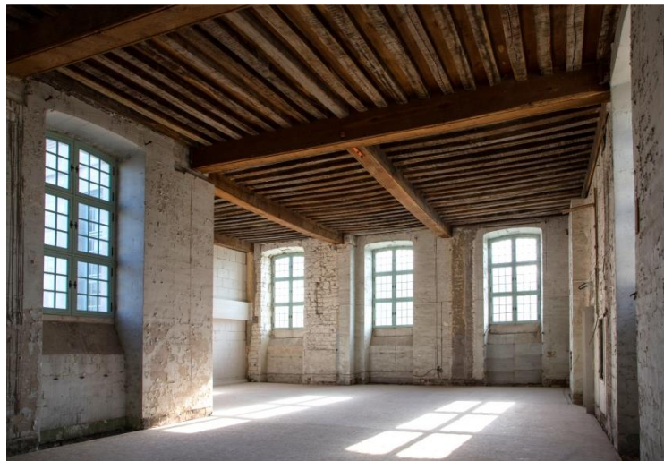
Salle du 2 e étage avant le chantier © Adrien Alleaume
