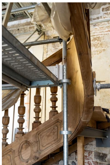
Poutres métalliques de soutien © Highlight Movies
