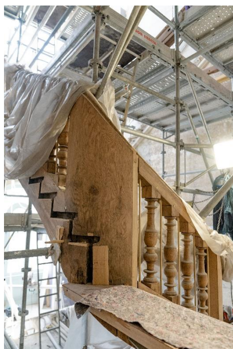
Repose de l'escalier © Highlight Movies
