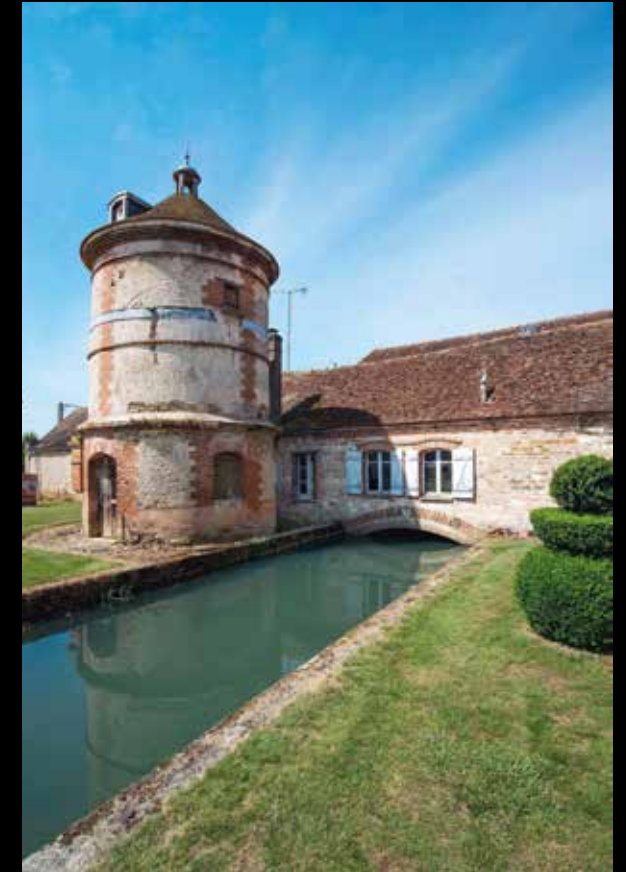
MONTIÉRAMEY. Le moulin de l'ancienne abbaye bénédictine a été reconstruit et étendu après la Révolution. Depuis la restauration de sa turbine, l'installation produit de l'électricité.
