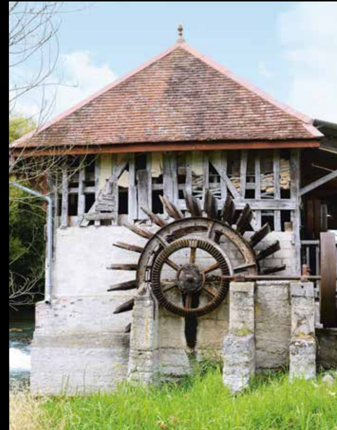
VINETS. Élevé en torchis et pan de bois sur la Lhuitrelle après la Révolution, consolidé ensuite de briques et de parpaings, le moulin à farine a conservé sa roue hydraulique.
