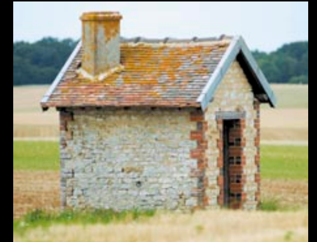
▼ RD 63 - MAGNANT LA BORDE Pierre pour les murs, brique sur les angles et autour de la porte, toit en tuiles plates, imposante cheminée. Des anneaux permettaient d'y accrocher les chevaux.
