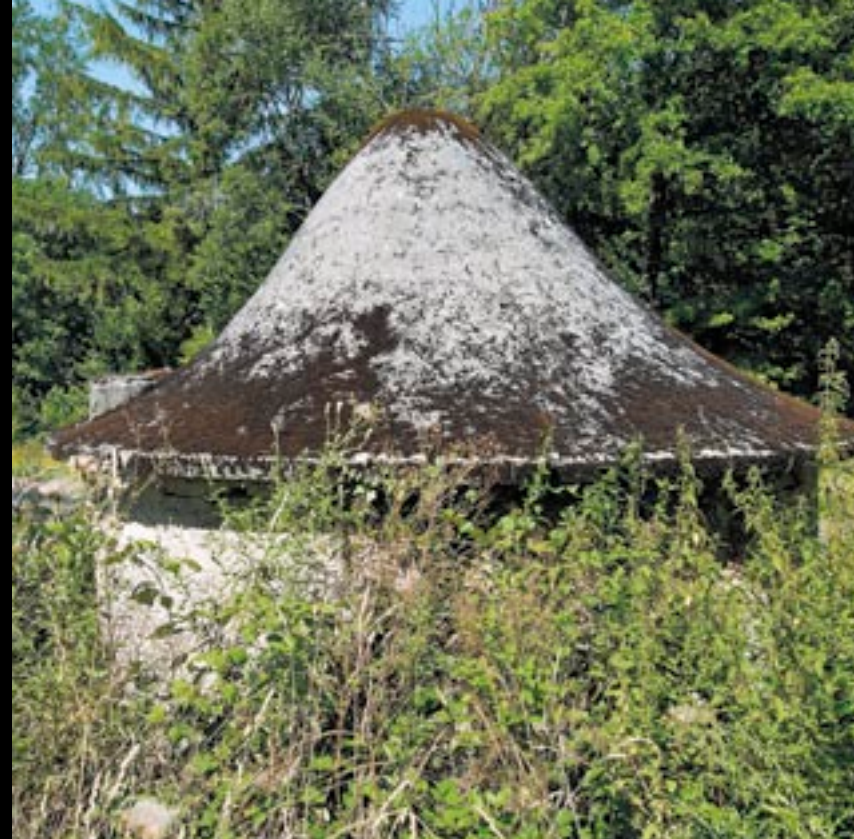
► RD 452 - BALNOT-SUR-LAIGNES Une double toiture: pierre sèche à l'extérieur, pierre maçonnée à l'intérieur. On s'y abrite toujours, mais pour attendre le car.
