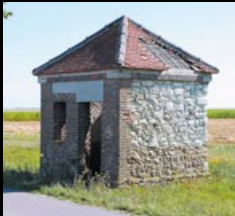
◀ RD 111 CHENNEGY L'abri étant très proche de la chaussée, le cantonnier a positionné la porte sur le côté.
