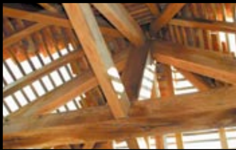
► RD 373 ÉTRELLES-SUR-AUBE SAINT-OULPH Une belle charpente, une fenêtre et un toit à quatre pans. Brouette, pelles, pioche, pic, rabots, râteau, masse, cordeau... le cantonnier devait souvent s'équiper à ses frais et entretenir ses outils en dehors des heures de travail.
