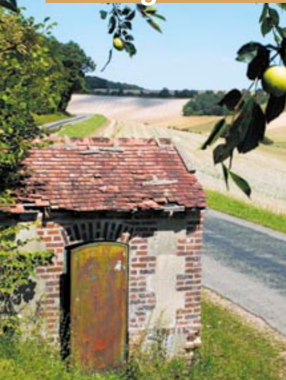
◀ RD 111 CHENNEGY L'abri étant très proche de la chaussée, le cantonnier a positionné la porte sur le côté.
