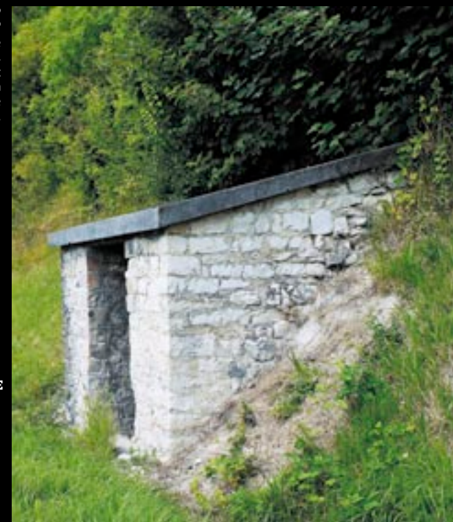
► RD 619 DOLANCOURT Encastré dans le talus, un abri avec un toit à pan unique en béton.
