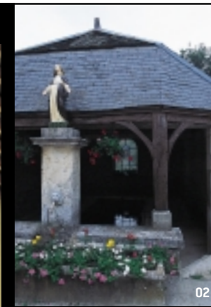
04 POLIGNY. Une toiture à quatre pentes, percée en son centre, dirige les eaux de pluie vers le bassin également alimenté par la source Ste Apolline.
