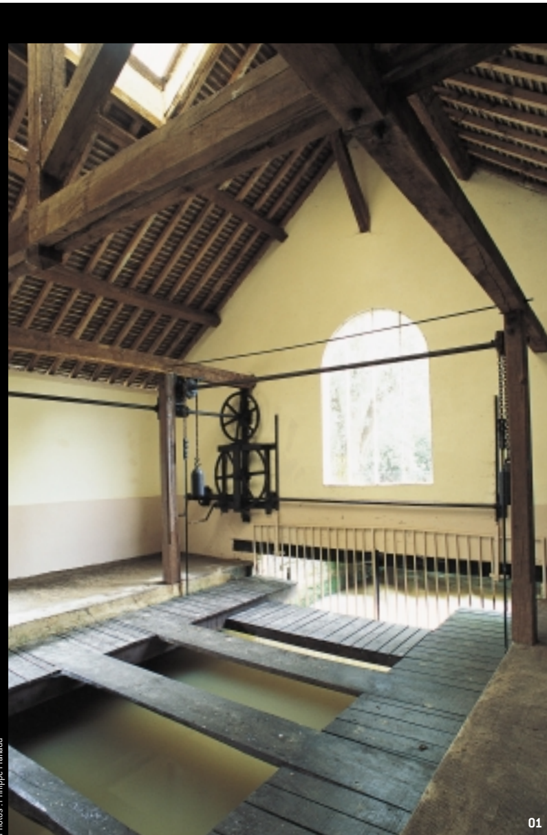
01 DAVREY. Un mécanisme permet d'ajuster le plancher. Restauré, ce lavoir (1913) sert de lieu d'exposition.
