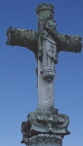
FONTETTE (1636) Sur cette croix de Bourgogne, le chapiteau a été malencontreusement retourné, lors d'une restauration.
