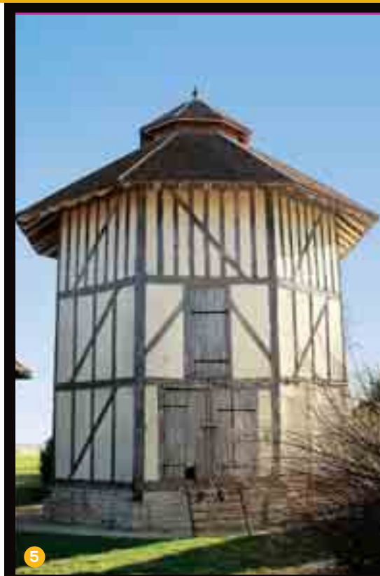
2 COURTERON Ferme de la Gloire-Dieu. Lucarne, corniche sous le toit et cordon « garde-rats » : des détails communs à tous les pigeonniers.
