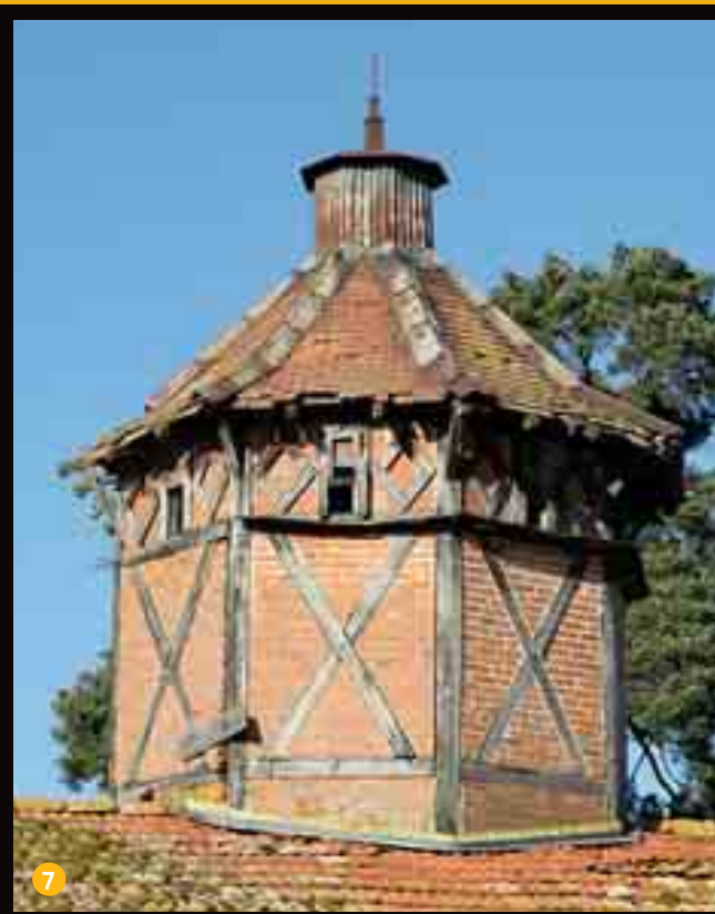
6 DROUPT-SAINT-BASLE Accolé à la ferme du château. Ouvertures en plein cintre. Détails maçonnés en briques. Et des pigeons pour épis de faitage !
