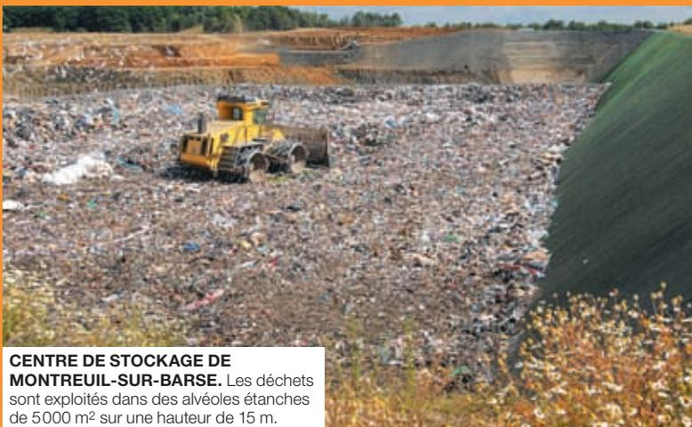
**CENTRE DE STOCKAGE DE MONTREUIL-SUR-BARSE.** Les déchets sont exploités dans des alvéoles étanches de 5000 m<sup>2</sup> sur une hauteur de 15 m.
