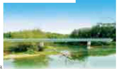
LE FUTUR PONT de la rocade sur la Seine à Bréviandes.
