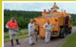
**POINT-À-TEMPS.** Grâce à cet engin, qui répand bitume et gravillons, la route est réparée "à temps", avant que les nids-de-poule se forment !
