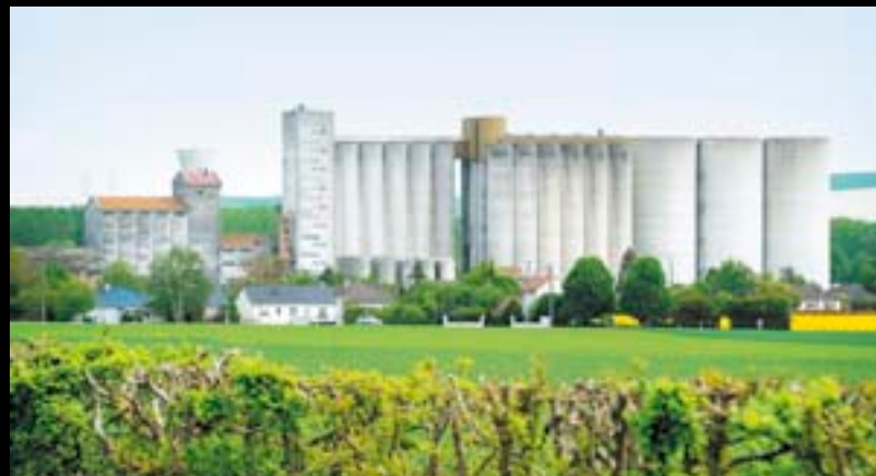
▲ SAINT-MESMIN. Quatre générations de silos. Les plus récents sont 6 fois plus performants que ceux des années 1960. Ils rejettent moins de poussières; le grain est mieux conservé.
