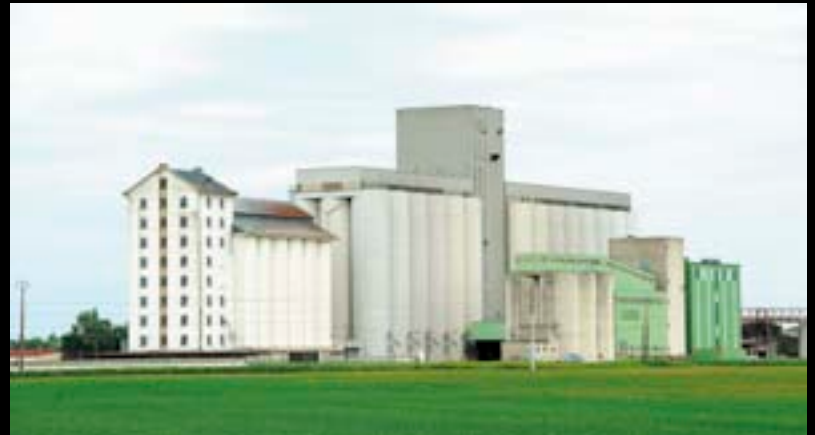
▶ CHÂTRES. Sur cette plate-forme de Vivescia, les céréales collectées sont séchées, nettoyées, désinsectisées et stockées. Ou divisées en lots pour être réexpédiées.
