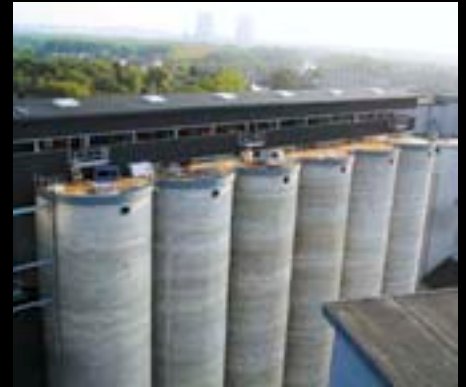
▼ NOGENT-SUR-SEINE. L'un des tout derniers silos verticaux en béton, construit par le groupe Soufflet pour les besoins de sa nouvelle malterie.
