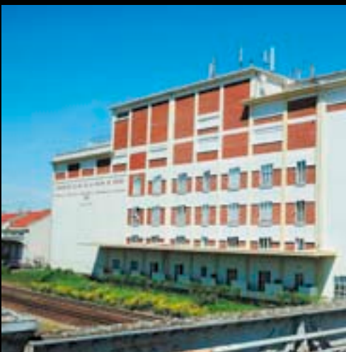
▲ SAINT-JULIEN-LES-VILLAS. Anciens silos de la coopérative de Troyes, construits en 1937, prolongés en 1953. Tels les anciens magasins à grains, ils ne laissent pas entrevoir leur forme. Le site abrite aujourd'hui des services et des logements.
