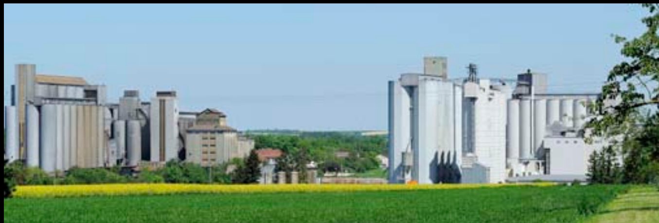
◀ ARCIS-SUR-AUBE. Les premiers silos, en ciment armé, fonctionnent dès 1929, alors que l'Aube est l'un des greniers à blé de la France. Au fur et à mesure des battages, les agriculteurs, réunis en coopérative, y entreposent leurs grains pour les vendre à l'époque la plus favorable.
