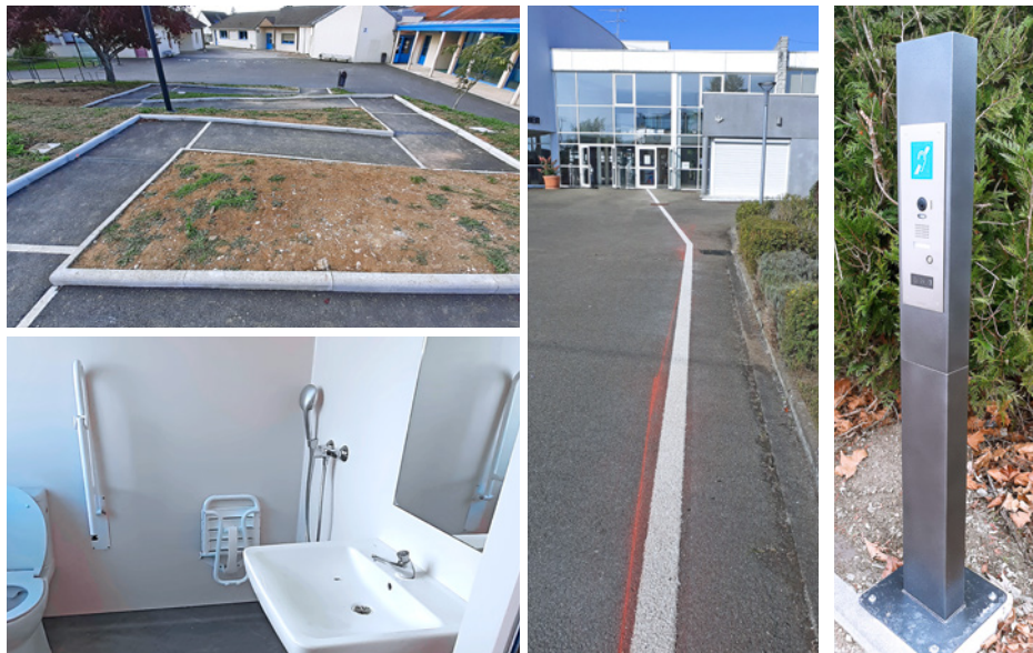
Rampes d'accès, sanitaires adaptés, fils d'Ariane au sol et avertisseurs lumineux ont été installés dans de nombreux bâtiments recevant du public.
